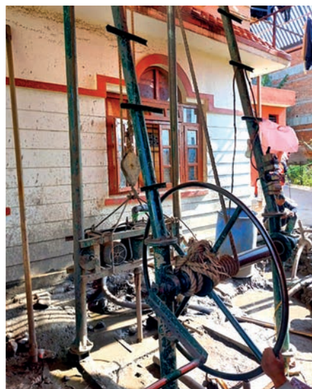
Forage du puits à la Snowland Ranag School
