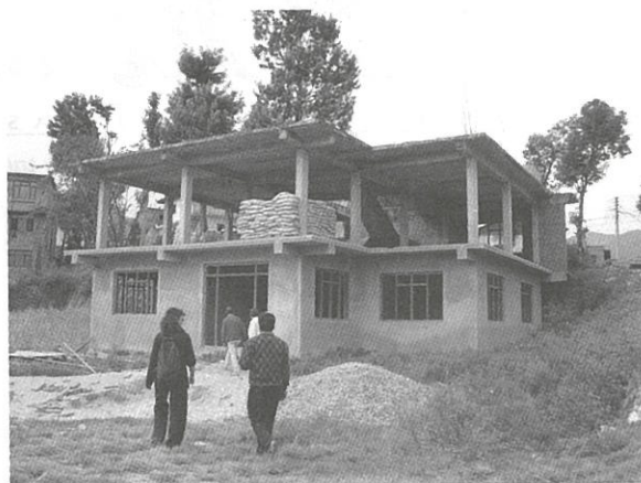
Le dispensaire de Pharping en construction.
