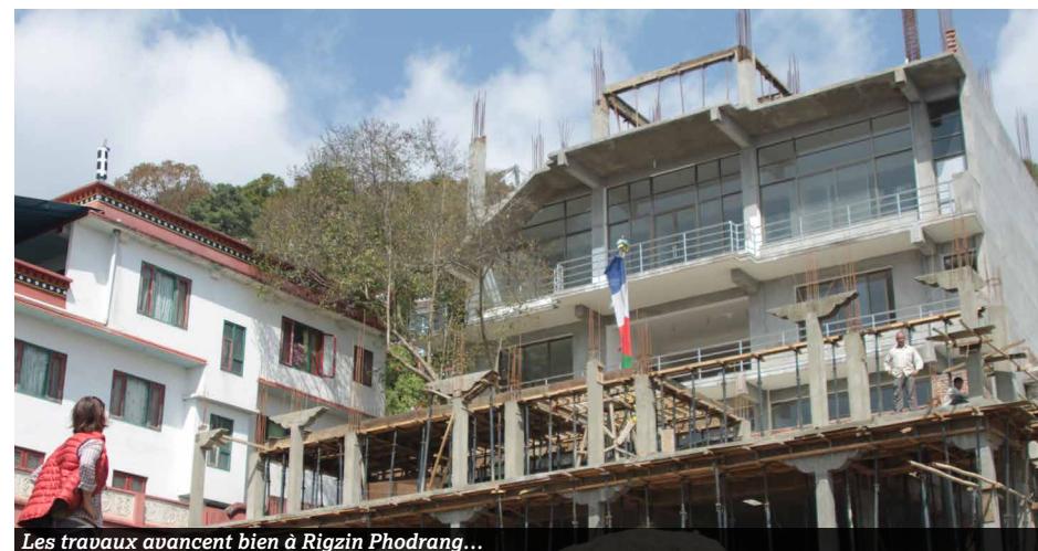
Les travaux avancent bien à Rigzin Phodrang...
