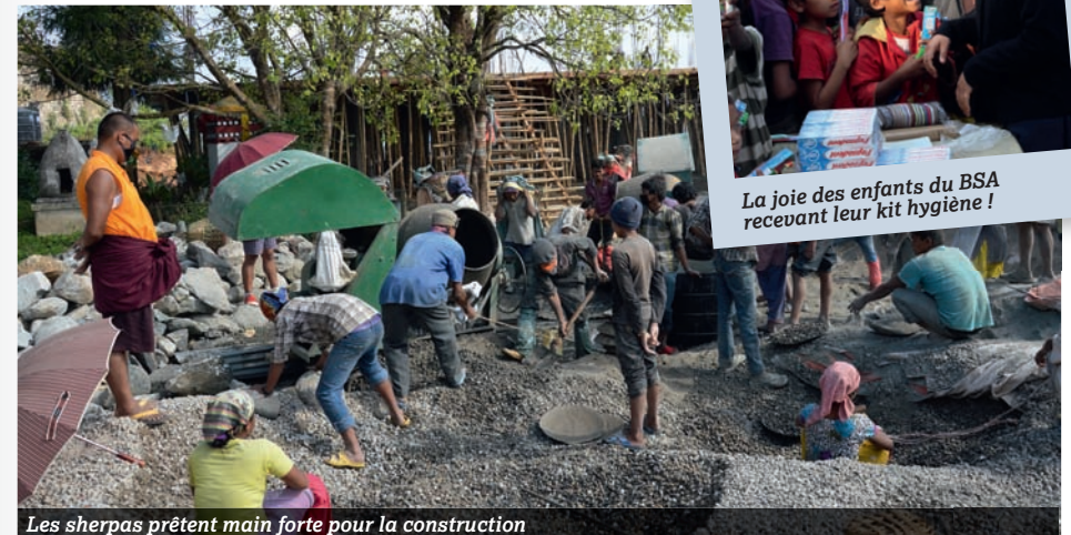
Les sherpas prêtent main forte pour la construction
